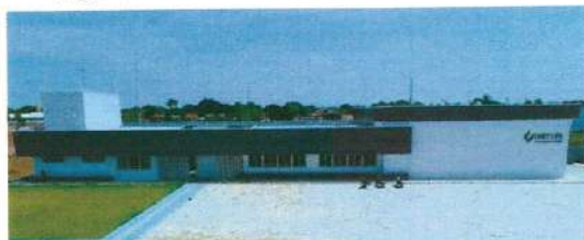
Figura 1 – Bloco de Laboratórios do IEA
